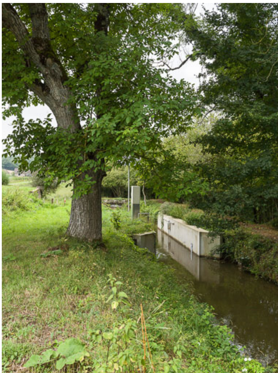
Vue de la rigole d'alimentation.
