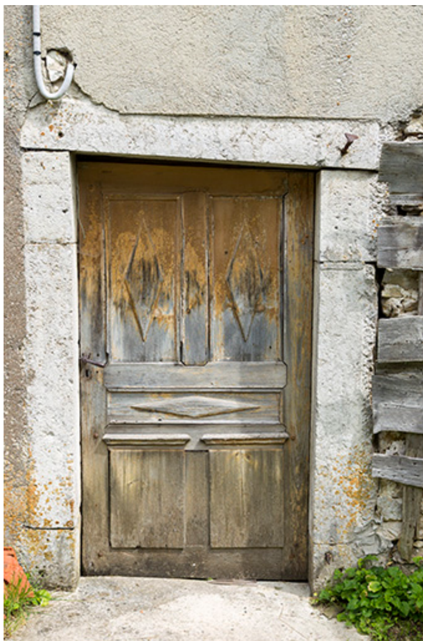
Façade postérieure : porte.
