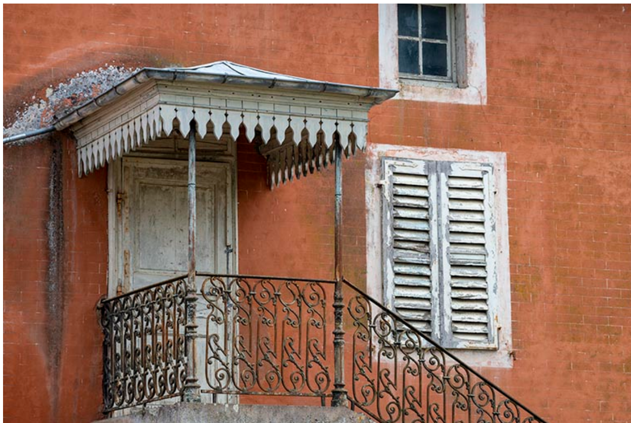
Façade nord, perron.
