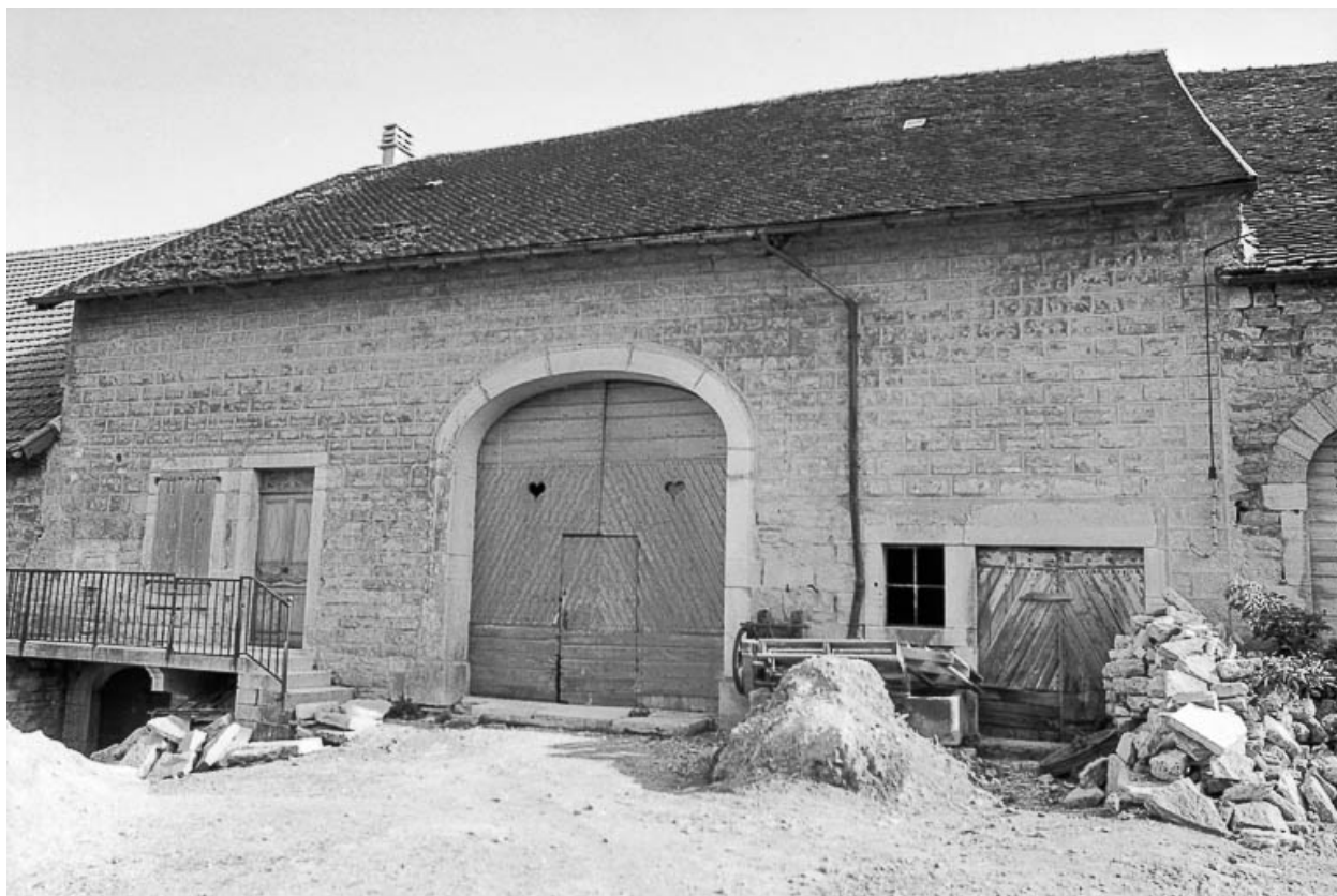
Ferme cadastrée D2 283 : façade antérieure.
