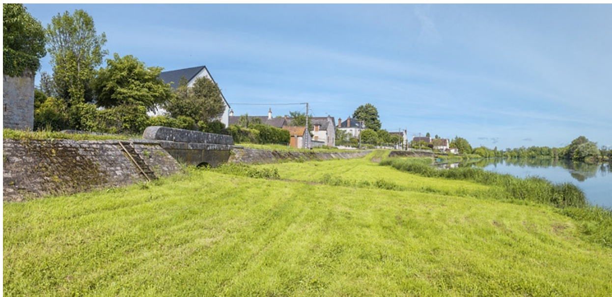
Ponceau au milieu de la digue.
