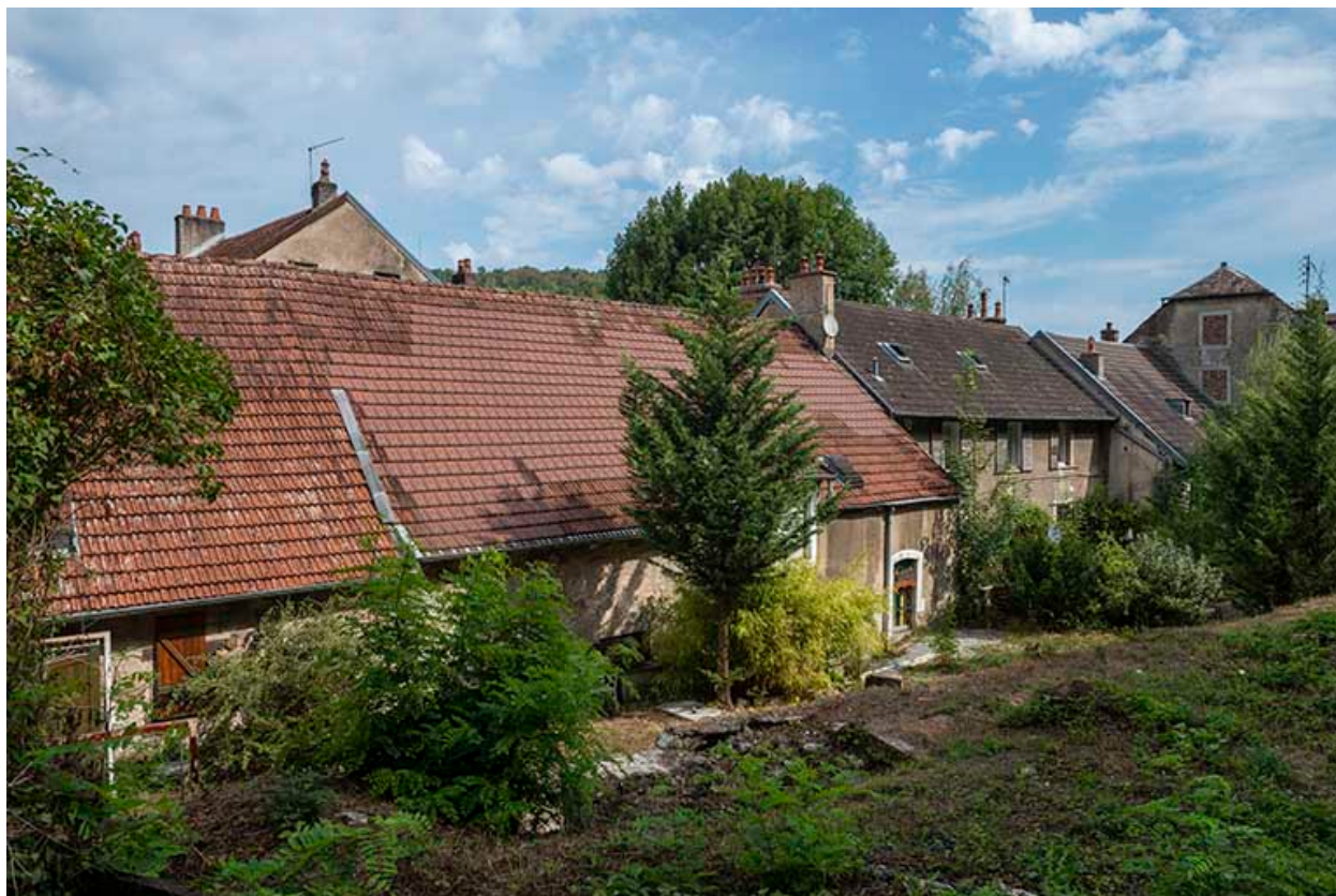
Façades sud des écuries, remises et logements.
