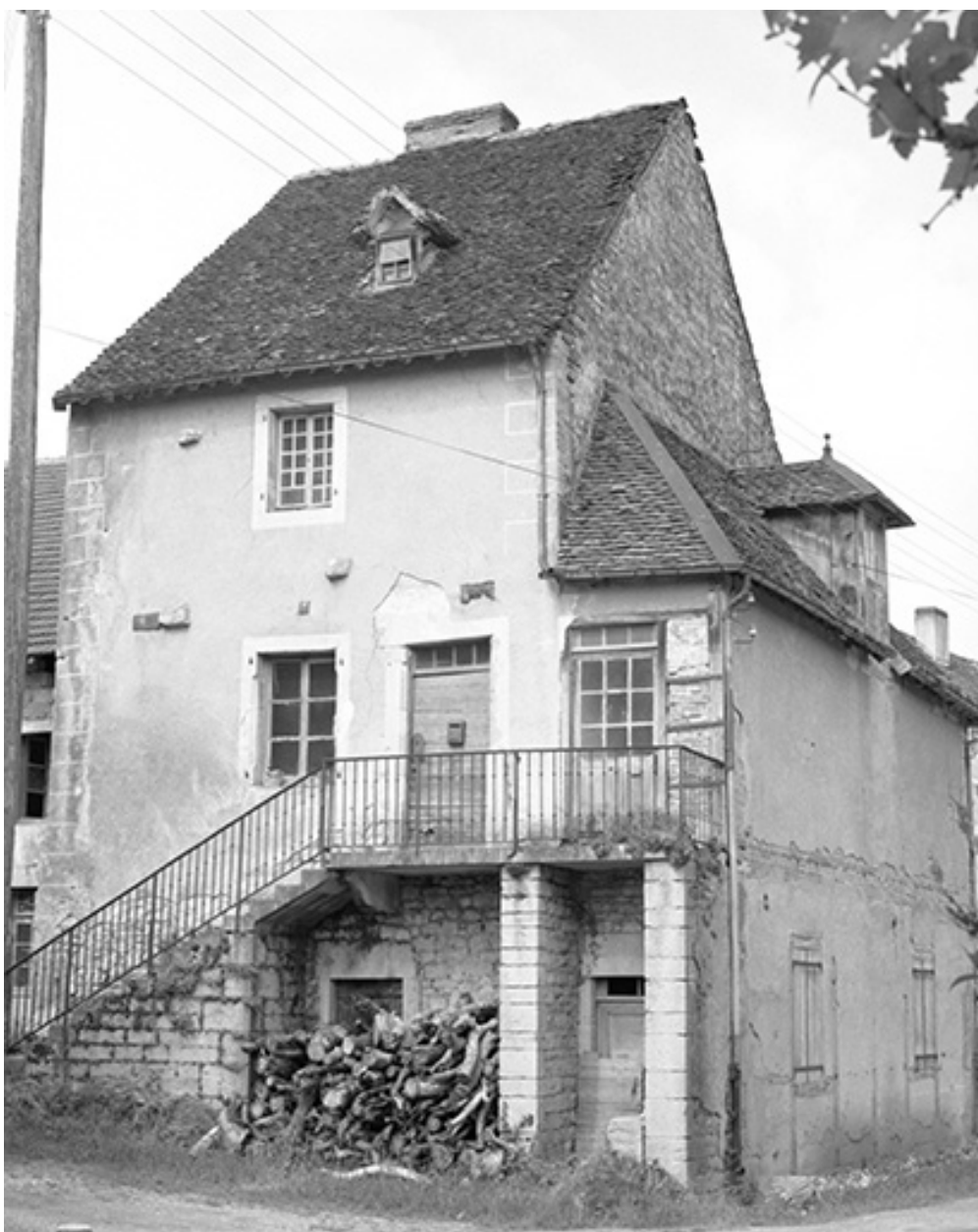
Maison : façades antérieure et latérale droite.
