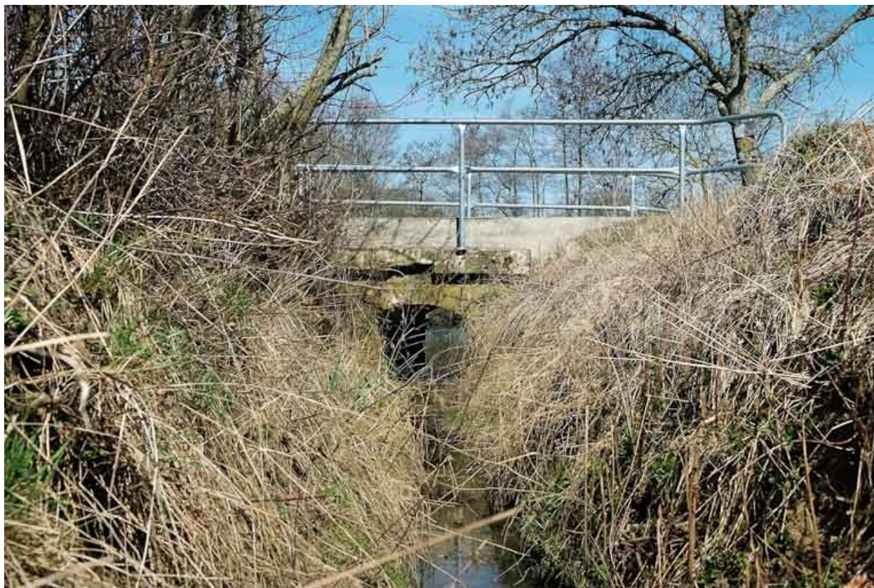
Ponceau, vue rapprochée.
