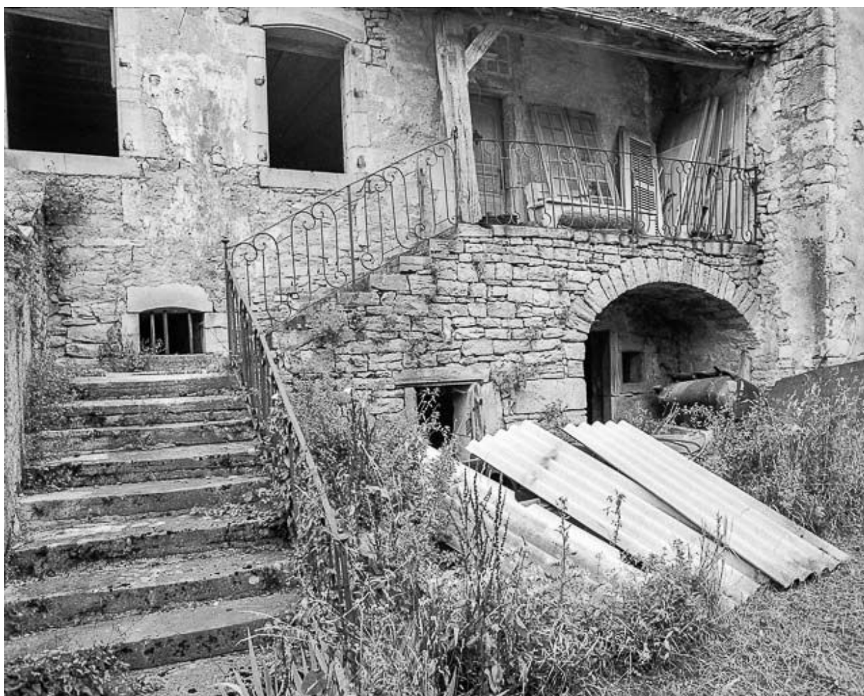
Détail de l'escalier.
