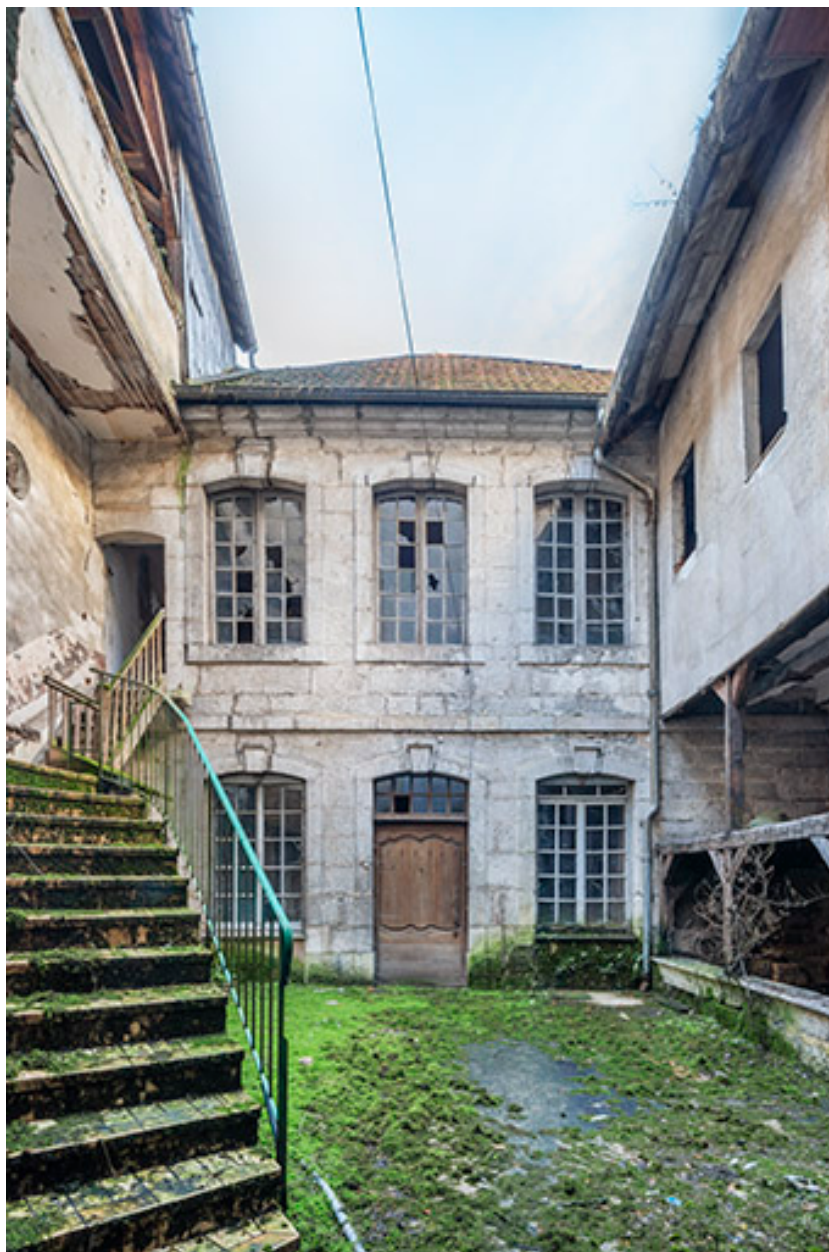
Façade est, depuis la cour.
