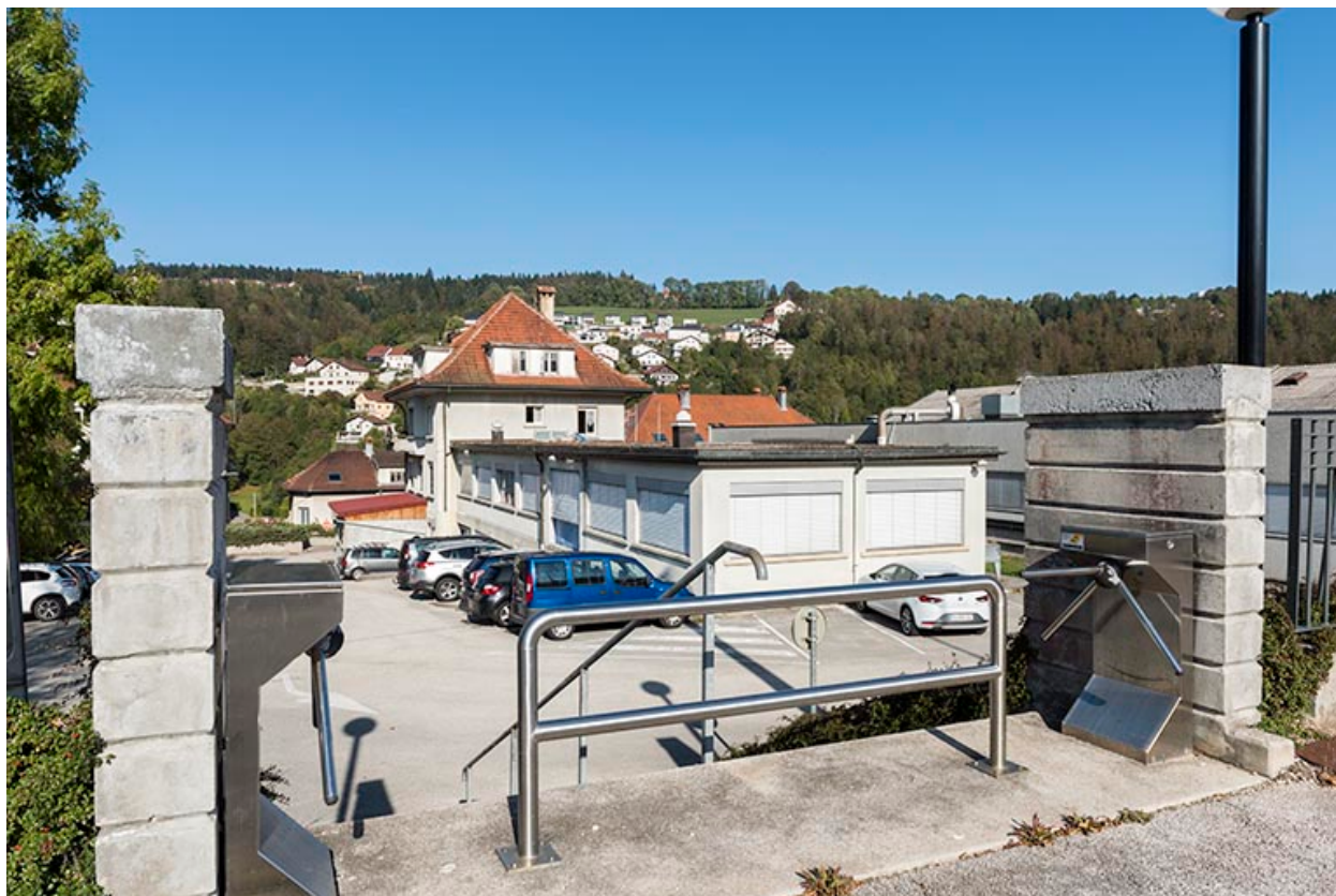
Entrée piétonne sur la rue des Gentianes.
