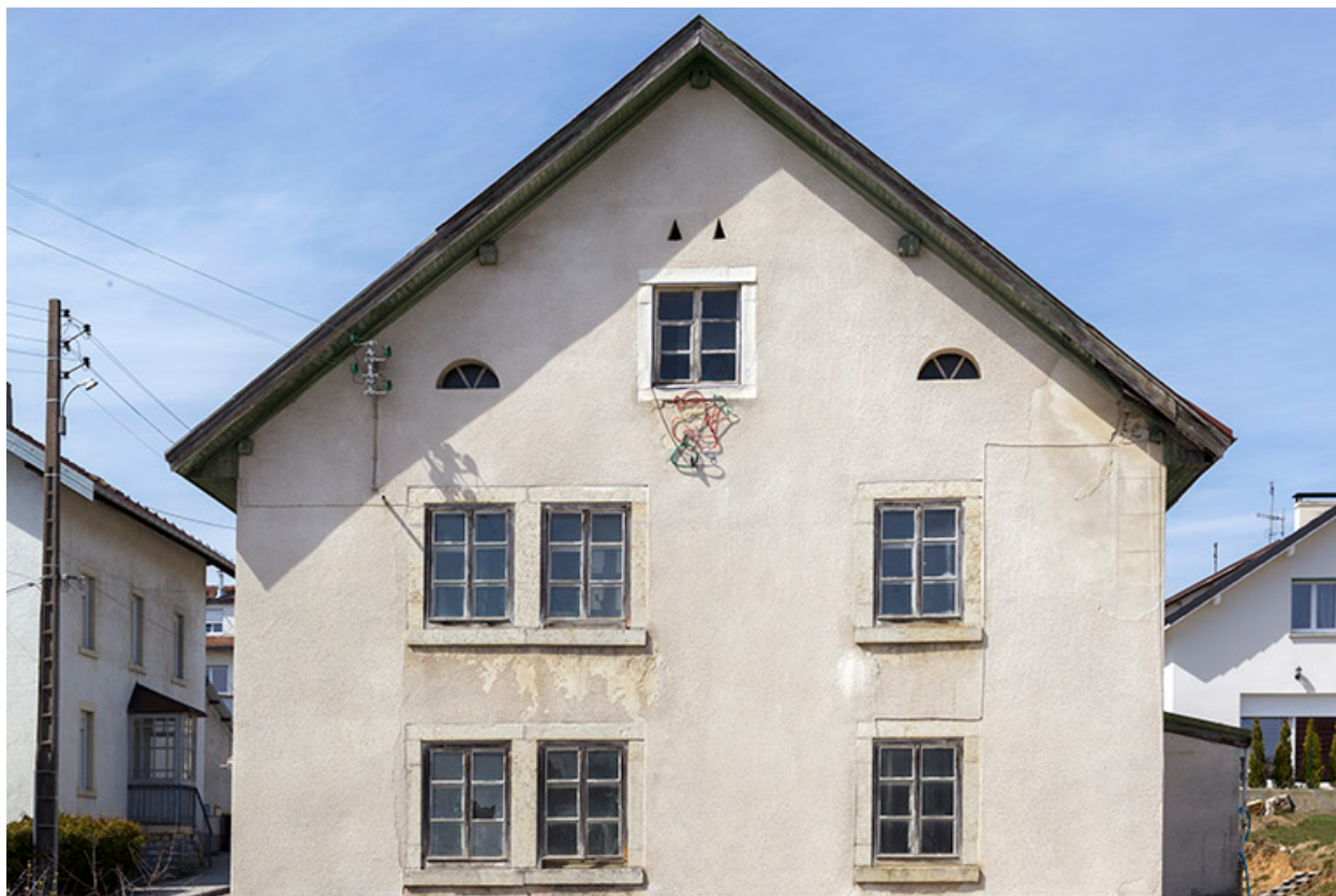
Façade latérale droite.
