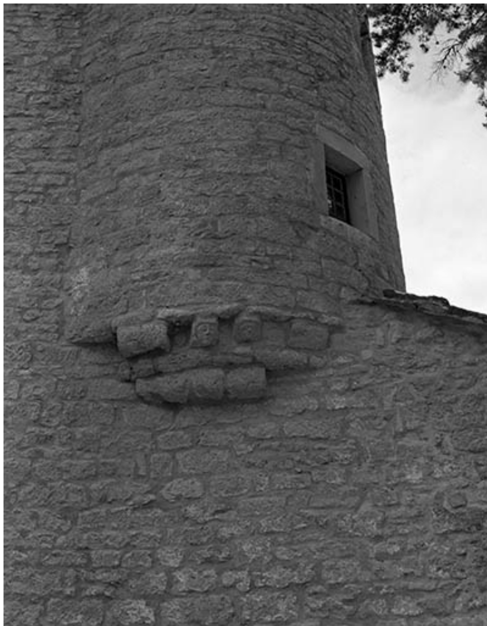
Encorbellement de la tourelle de l'angle nord-est
