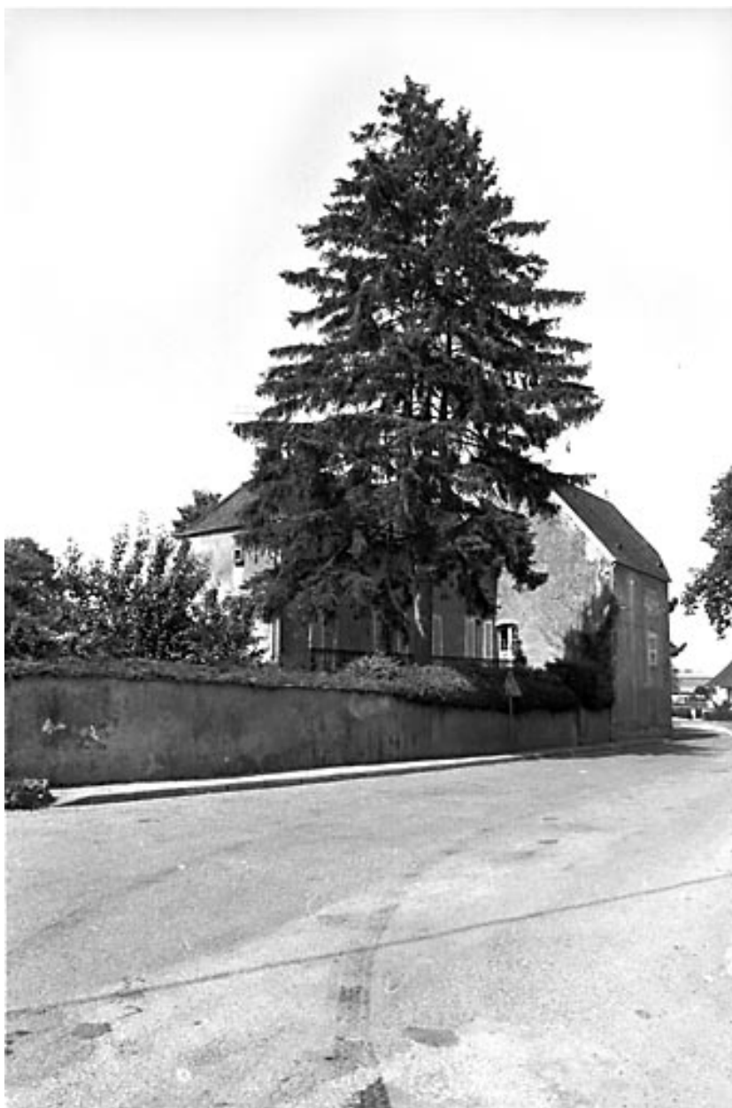
Maison située rue des Promenades : vue d'ensemble.
