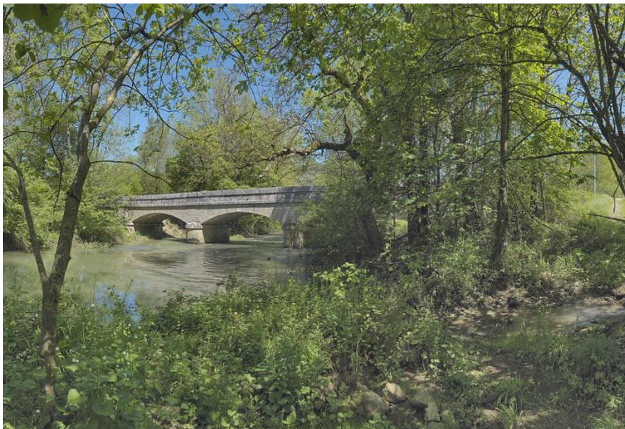
Pont isolé sur l'Ouche.
