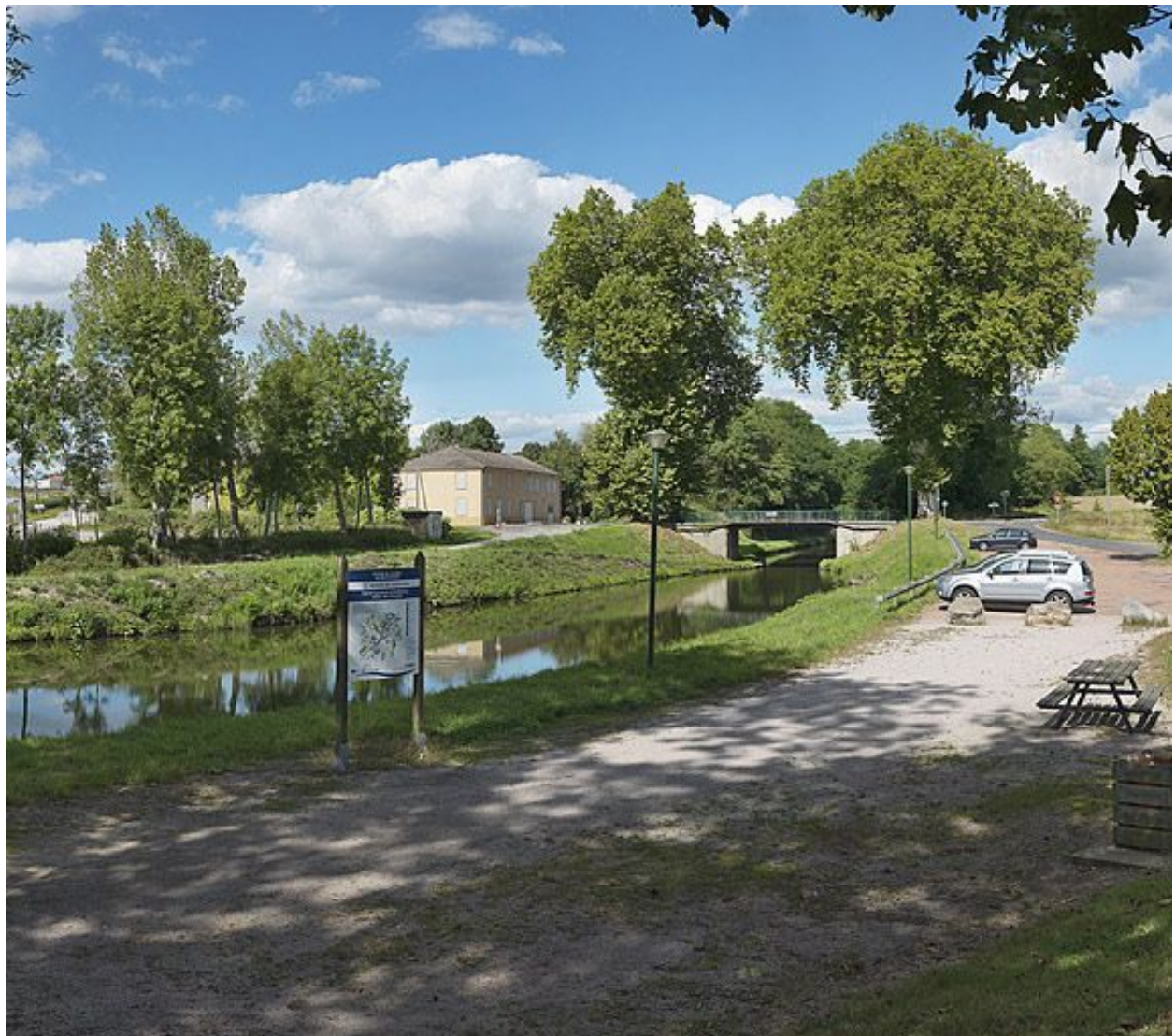
Le pont vu d'amont.
