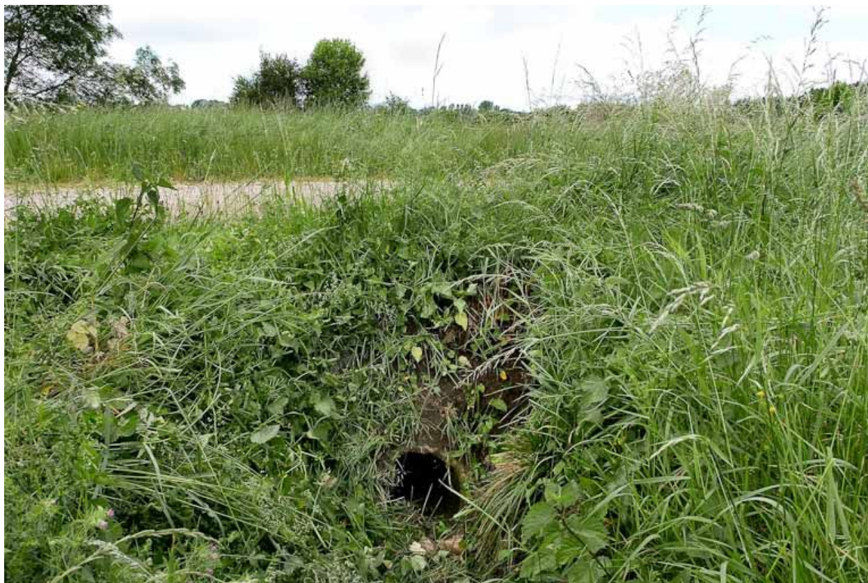
Un aqueduc moderne à Sornay.
