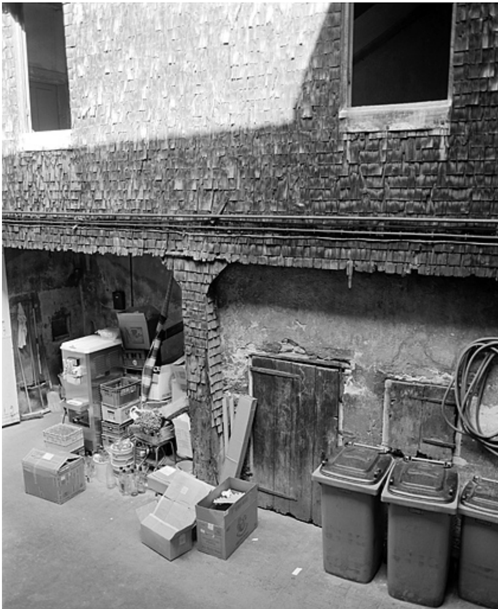
Escalier dans la cour, partie inférieure.
