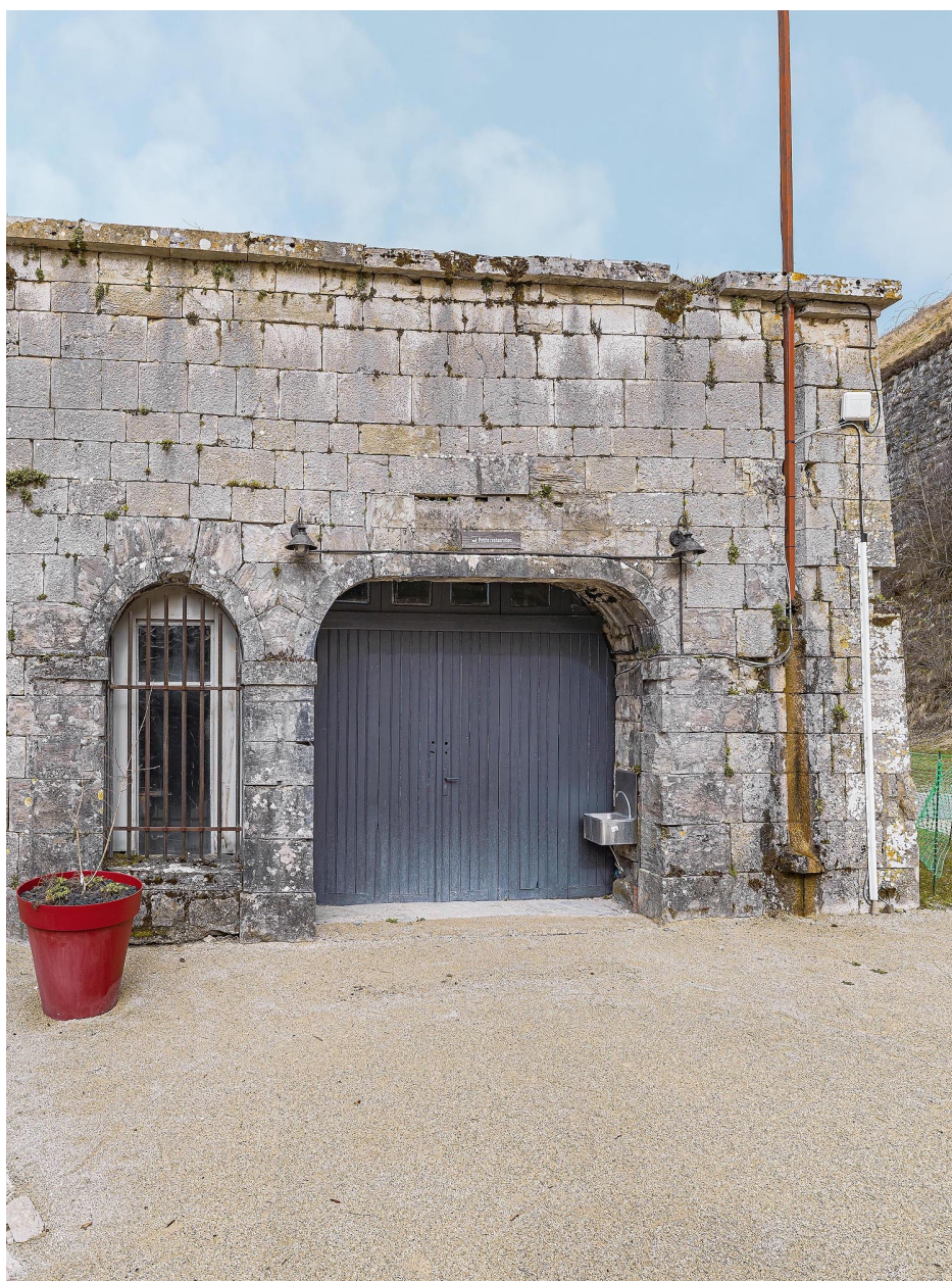
La casemate du corps de garde.
