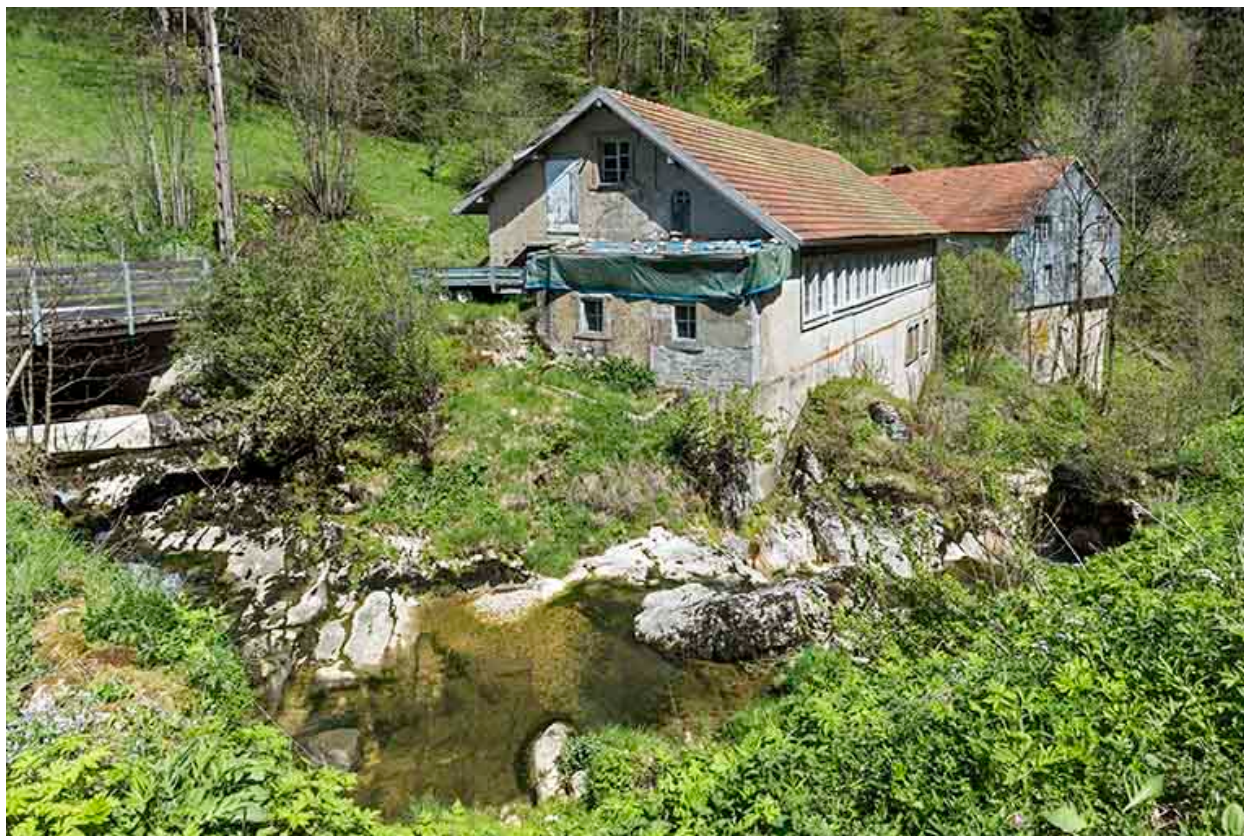
Usine et ancien moulin, depuis le sud.
