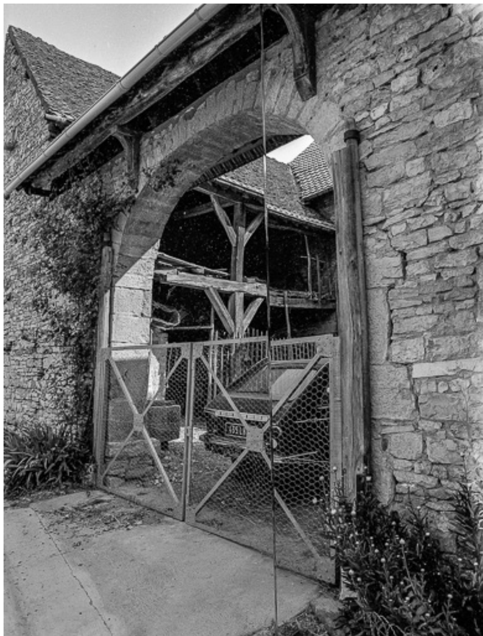
Cour intérieure, côté gauche : remise.
