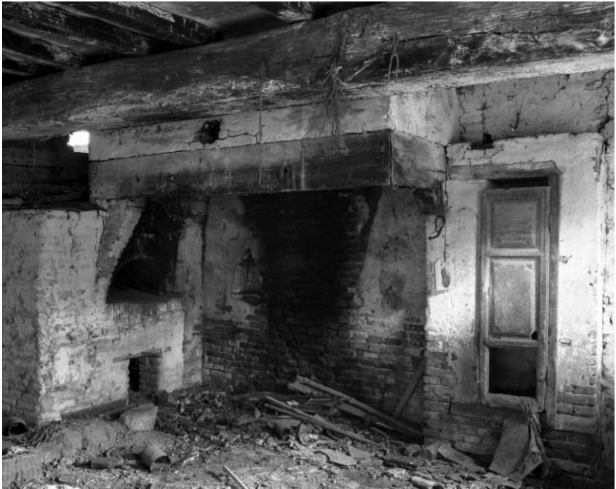
Pièce commune du logis.
