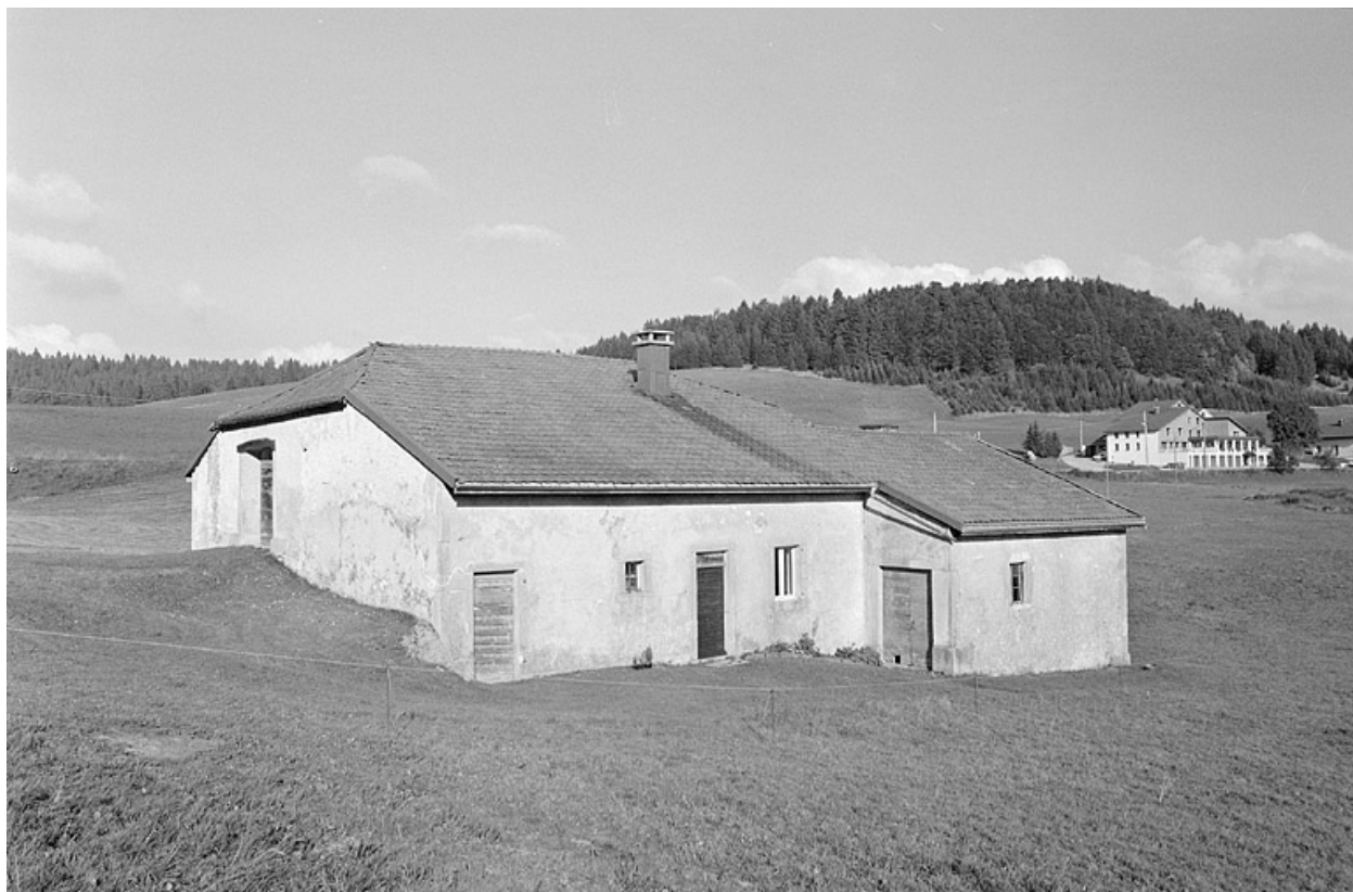
Façade antérieure et face nord-ouest.
