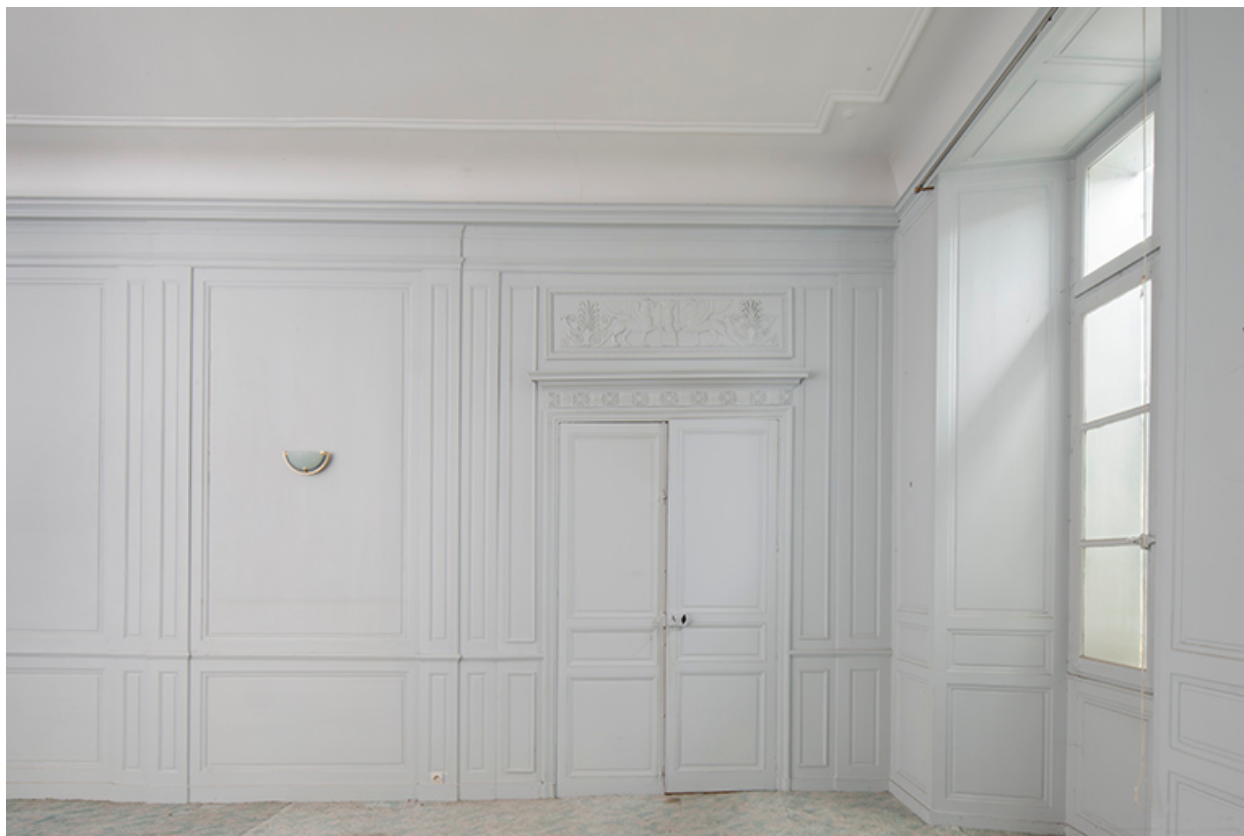
Aile nord. Pièce du premier étage.
