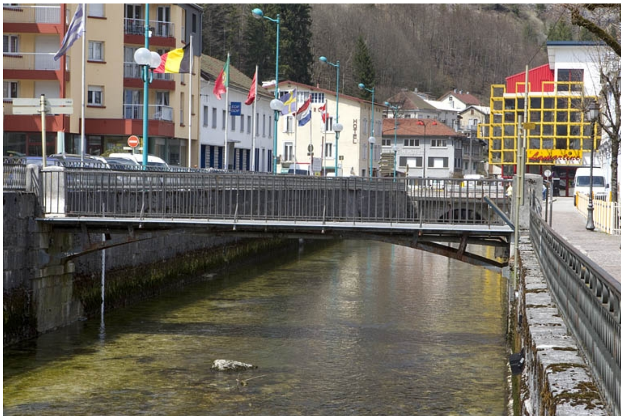
Passerelle aval, vue de l'amont.
