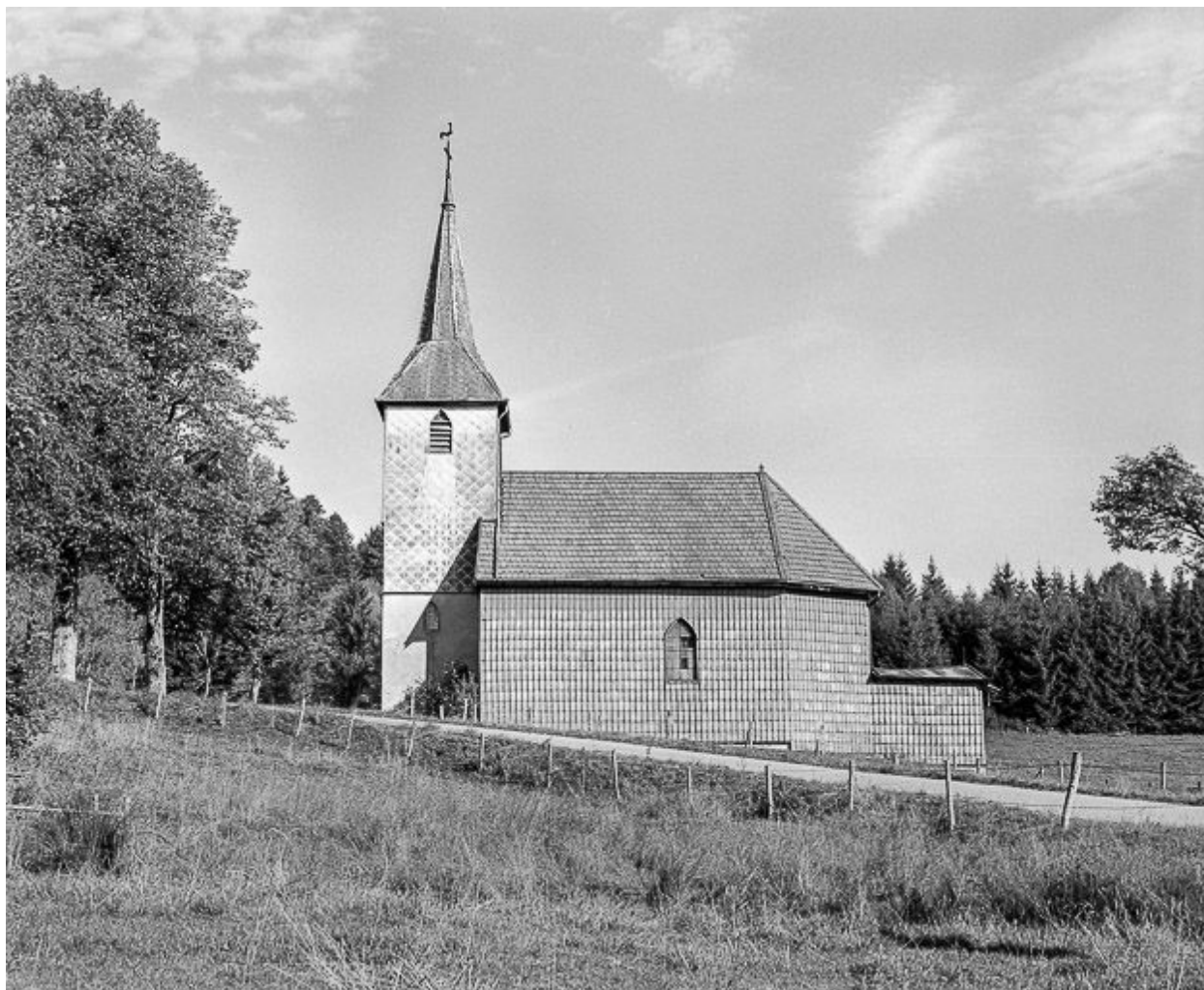
Façade latérale droite.
