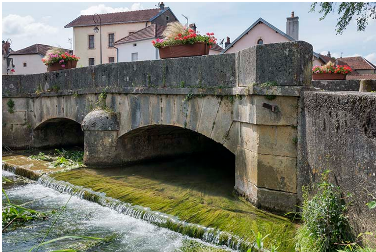
Face sud, vue depuis l'est.
