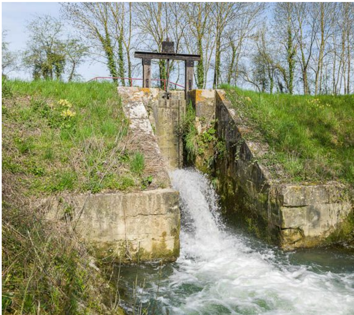
Le déversoir en contrebas du canal.
