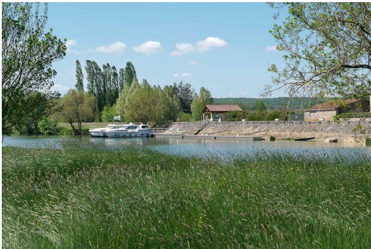
Digue protégeant La Truchère, avec port.
