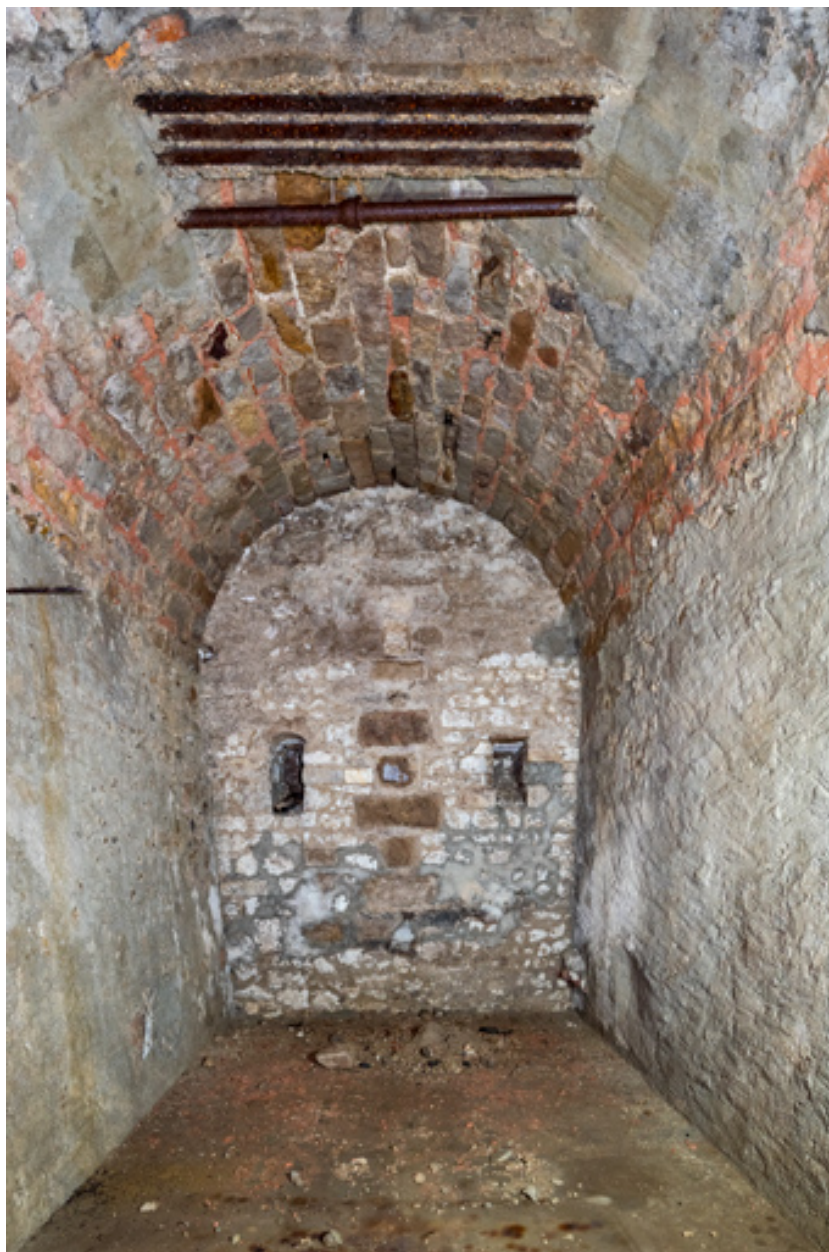
Ancienne halle au blé : cave voûtée sous la terrasse.
