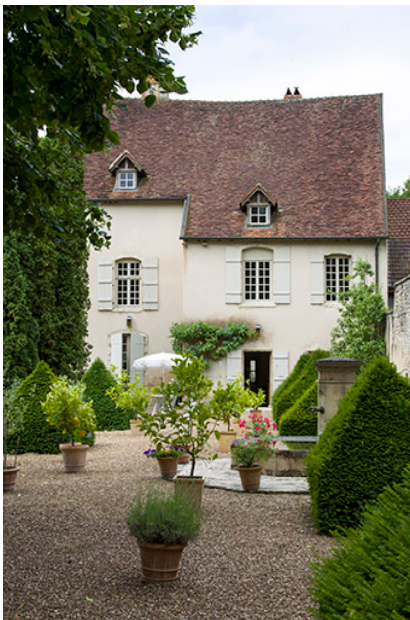
Façade postérieure donnant sur le jardin.
