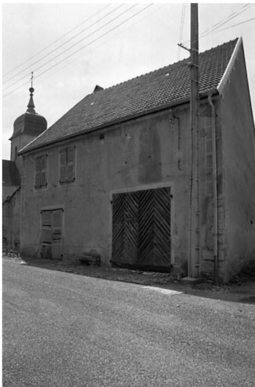
Maison située route de Motey-Besuche.
