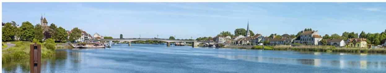
Vue d'ensemble d'aval.
