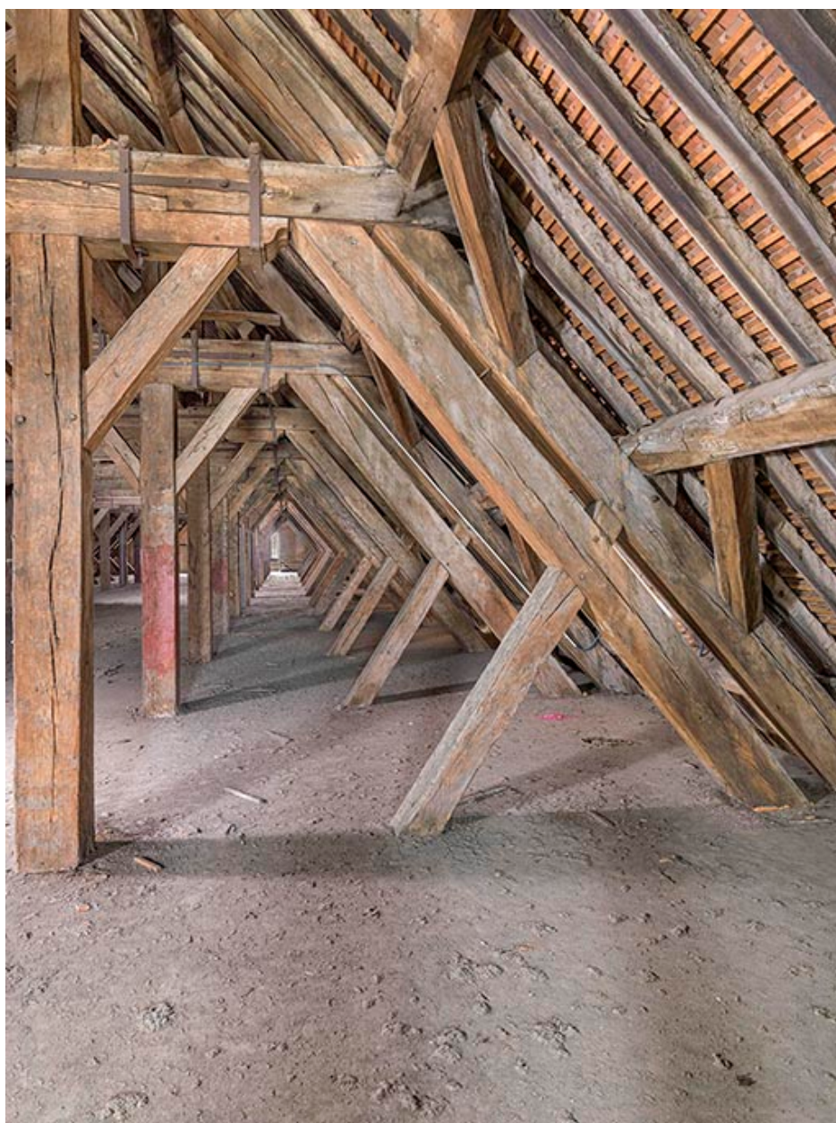
Détail de la charpente à chevrons-portant-fermes.
