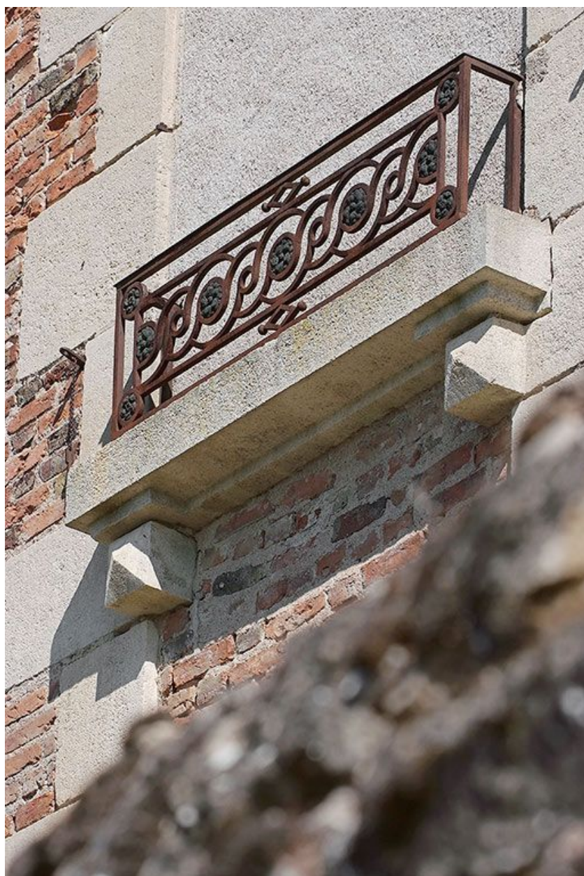
Détail du garde-corps.
