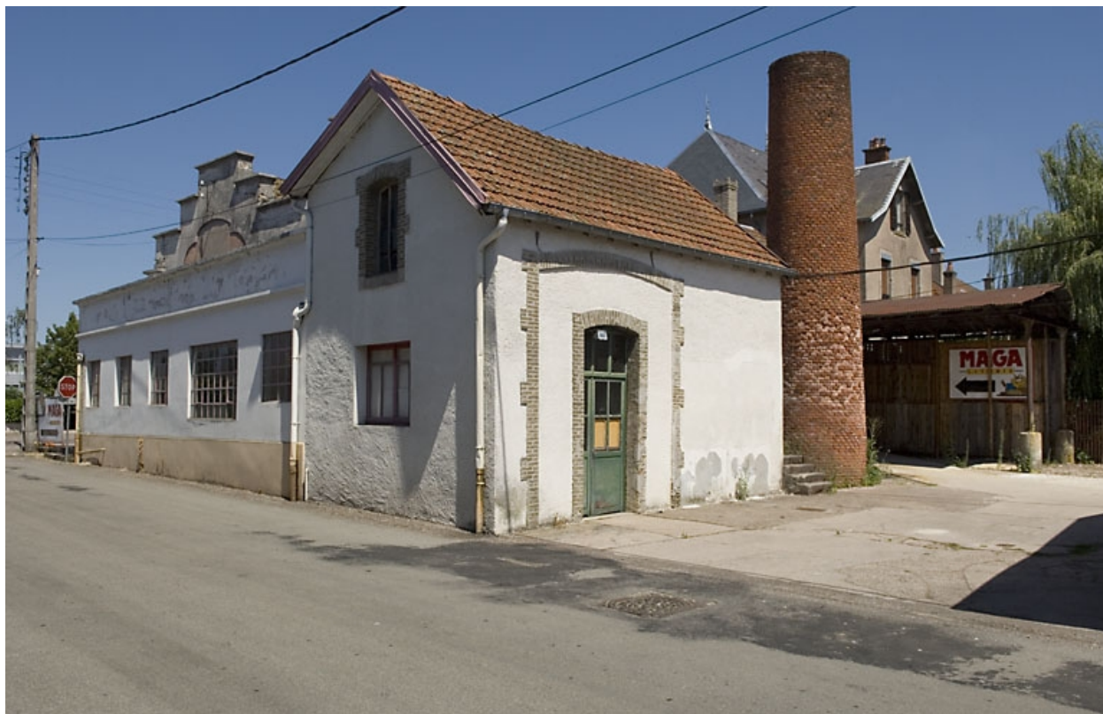
Vue depuis la rue de la République.
