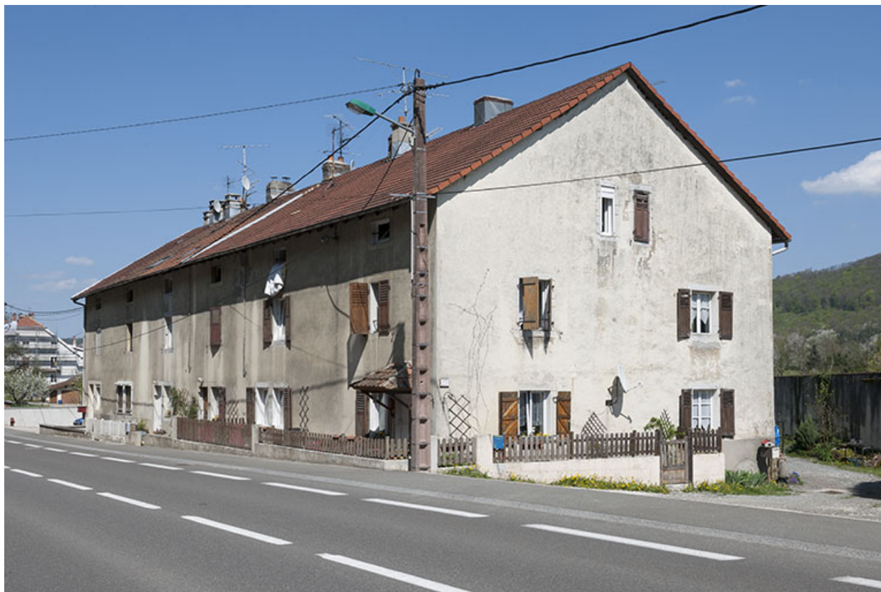
Logement d'ouvriers vu de trois quarts droite.
