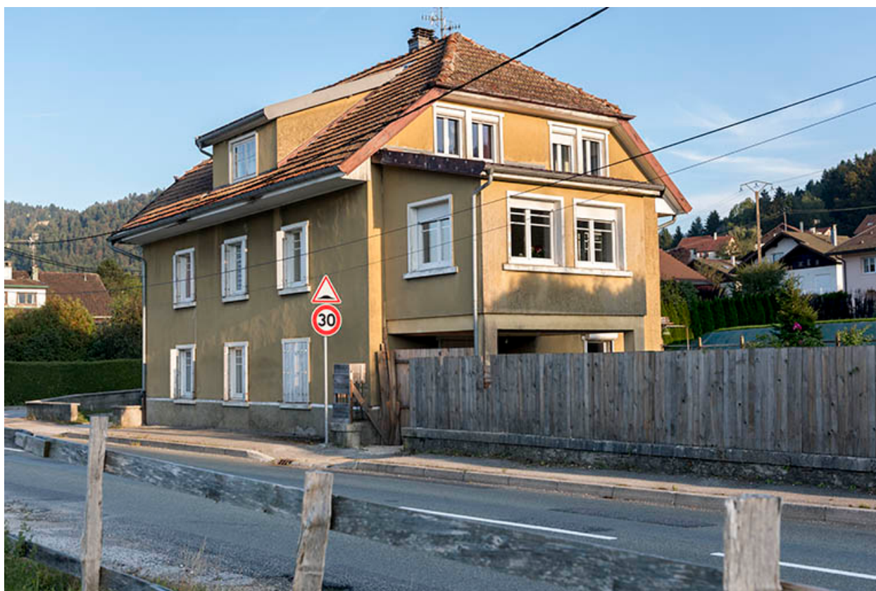
Façades antérieure et latérale droite.
