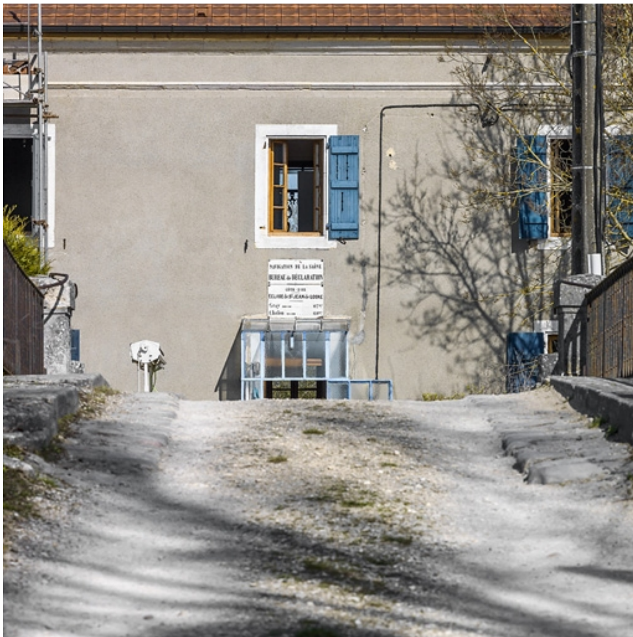
Maison éclusière : vue rapprochée sur la plaque.
