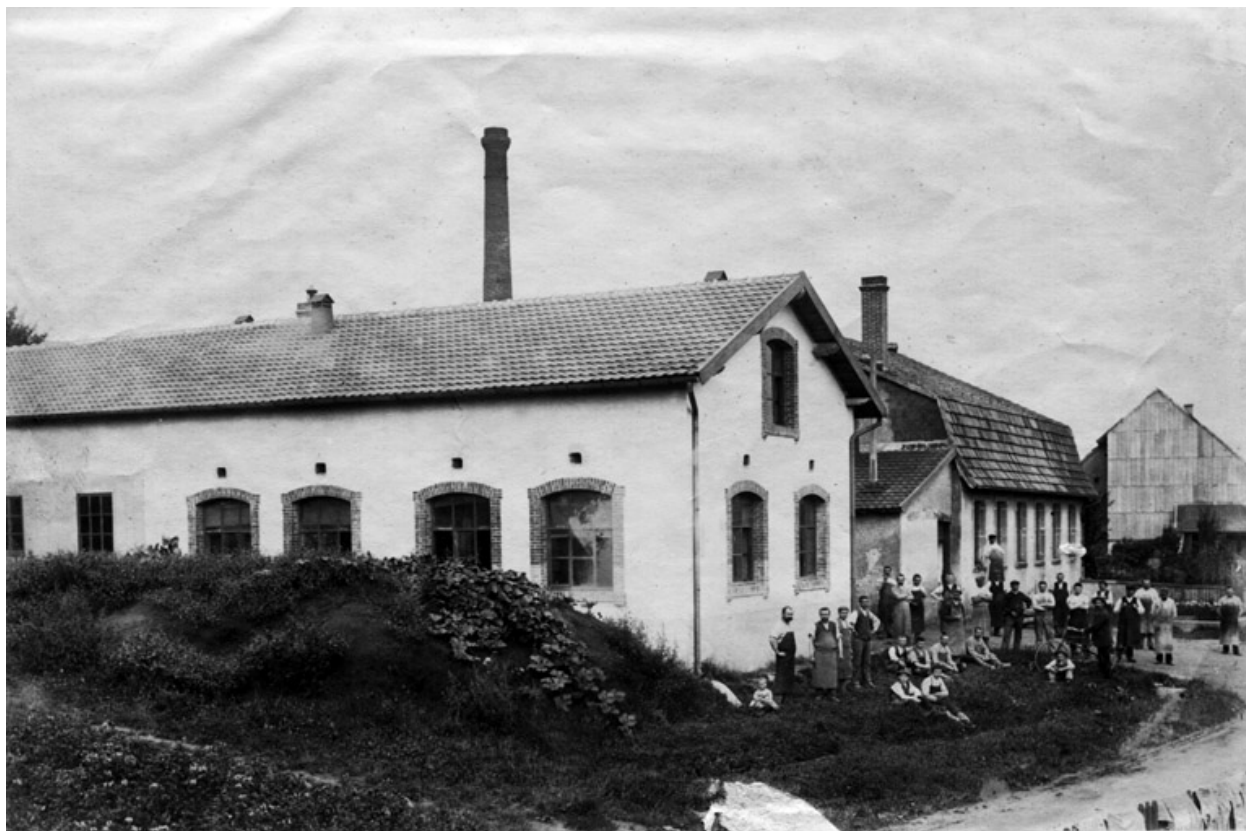
[Usine Ferrand à Grand-Charmont]. Photogr., s.n., s.d. [début du 20e siècle]
