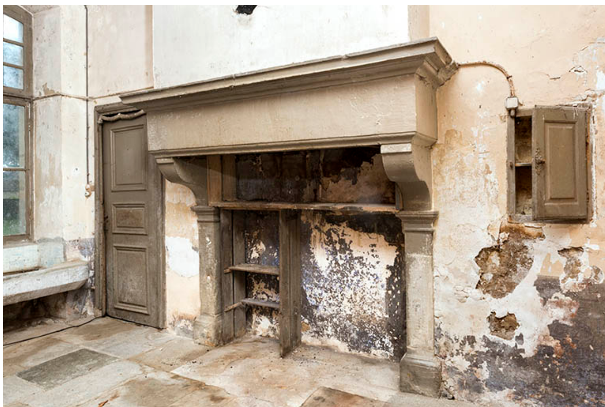
Cheminée au rez-de-chaussée. (Cuisine.)
