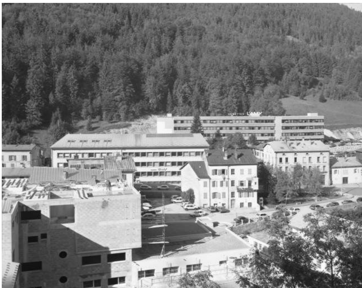
Site récent : vue d'ensemble.
