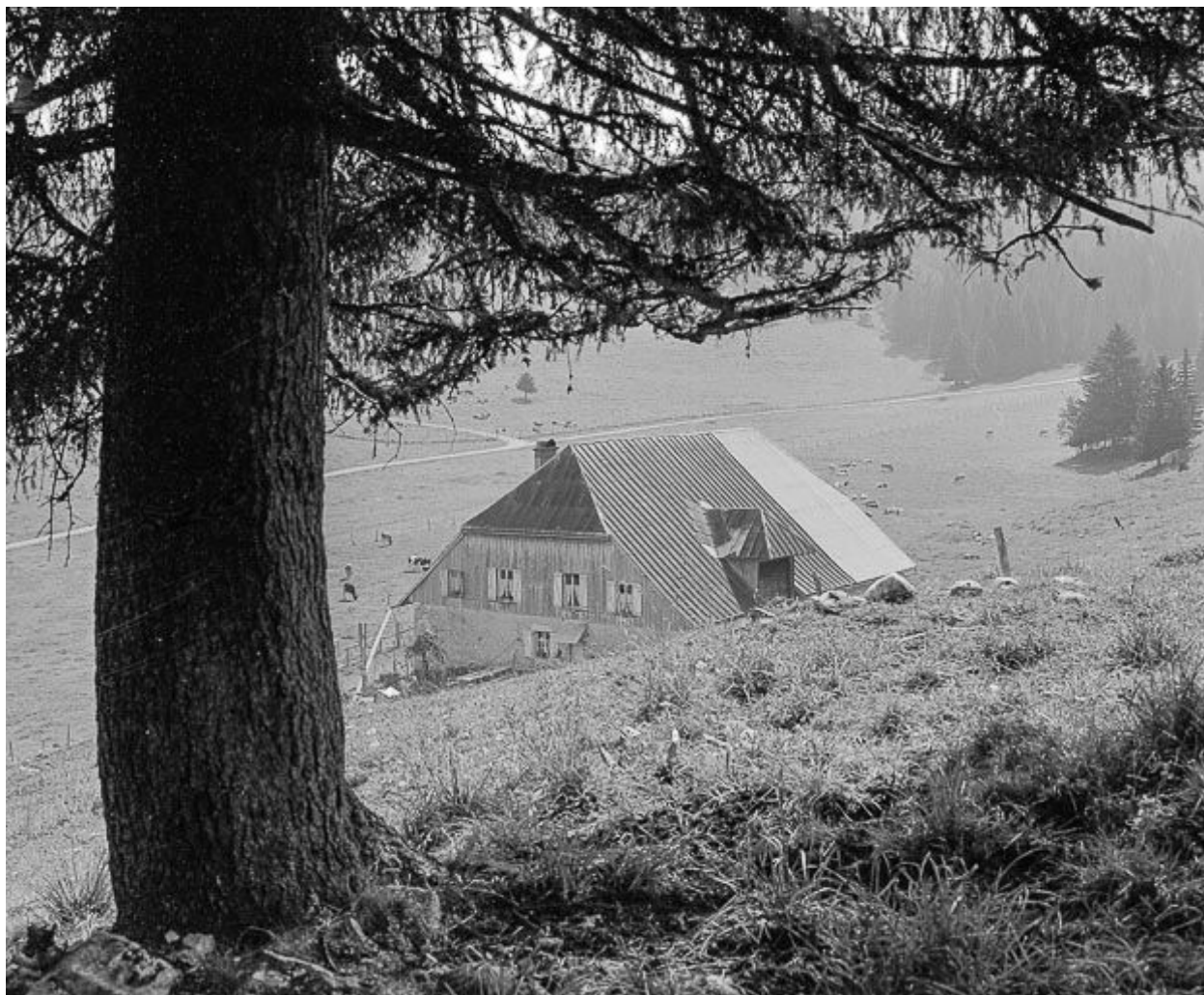
Pignon antérieur et goutterot droit.
