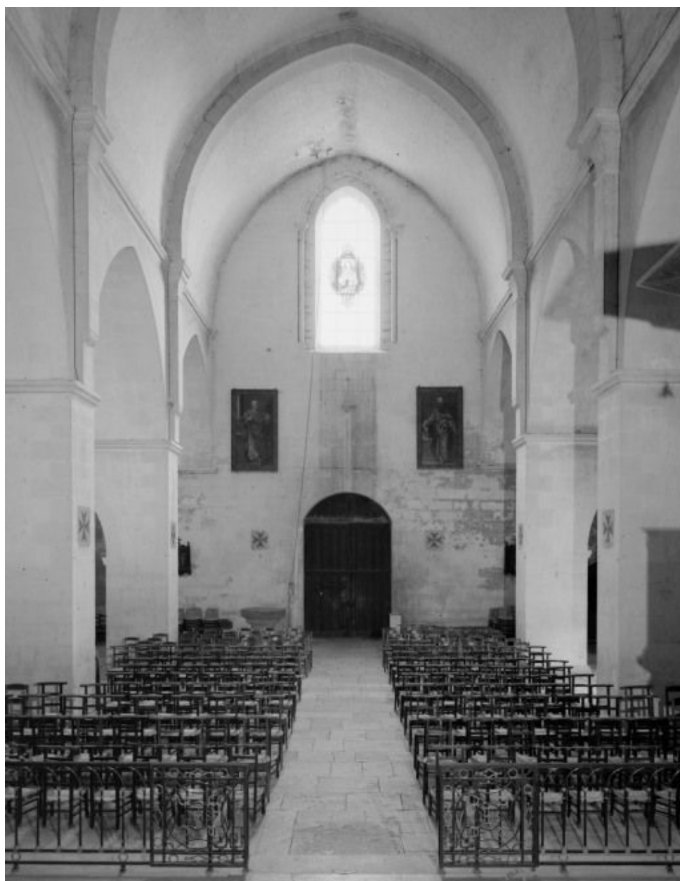
Eglise : nef, vue prise du chœur.
