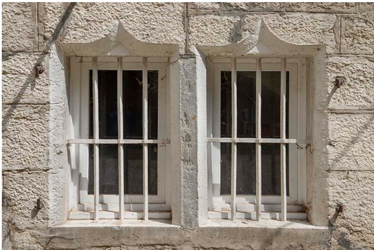
Façade est. Ouvertures du rez-de-chaussée.
