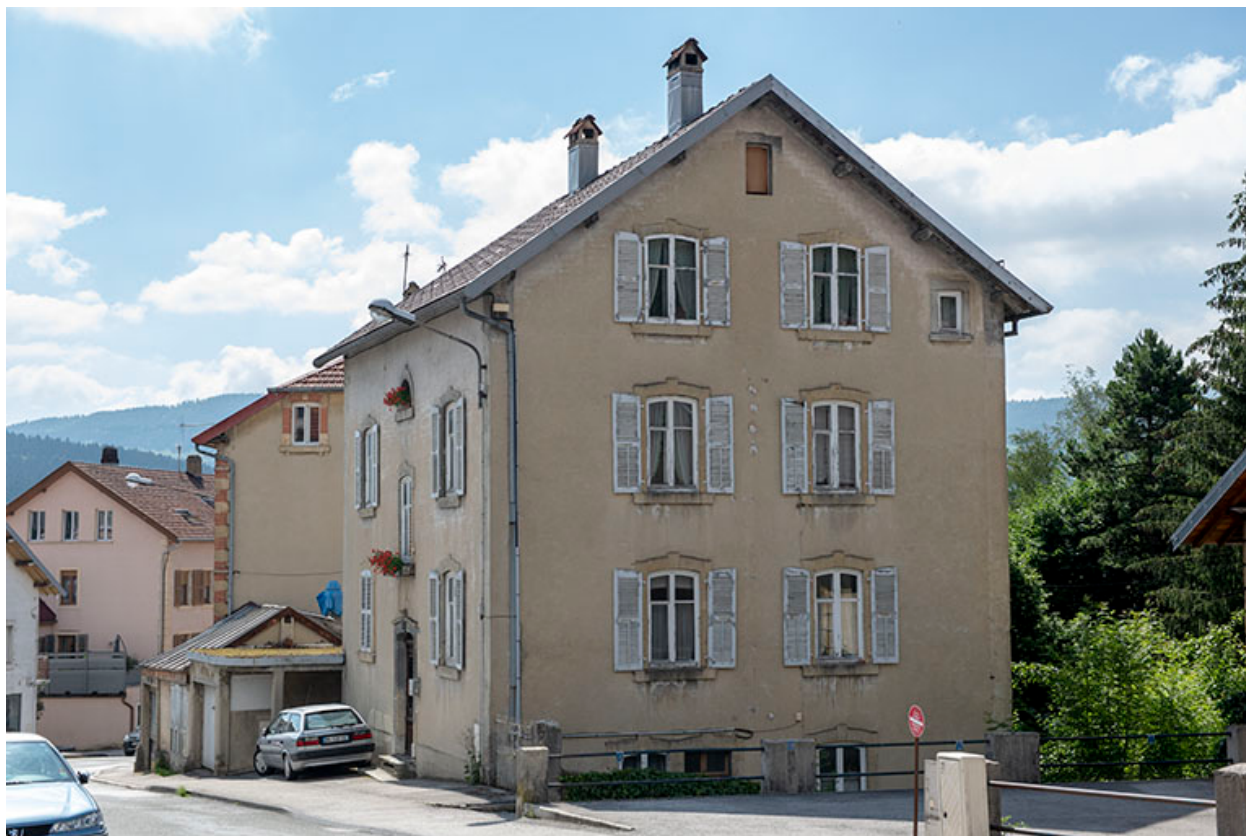
Façades latérale droite et antérieure.
