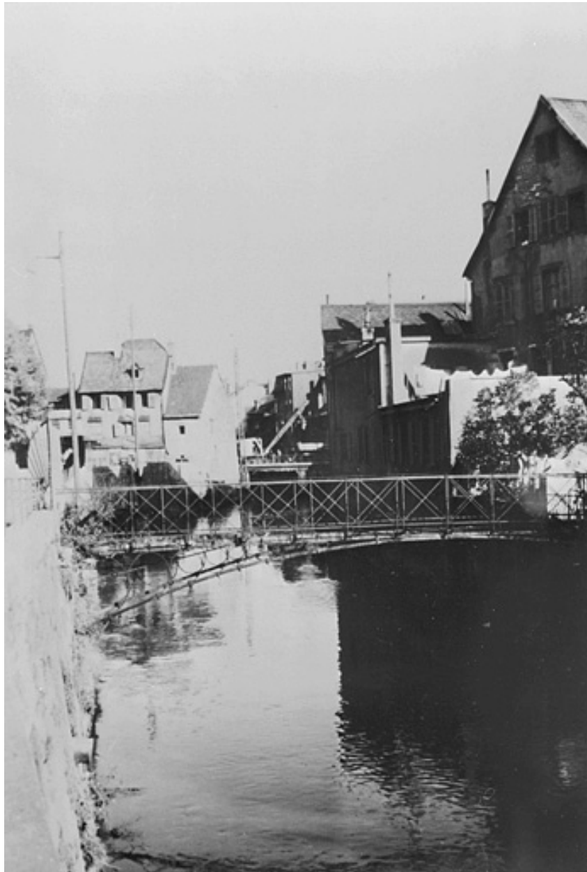
Passerelle de la tannerie Lods-Perdrizet [côté aval], début 20e siècle.
