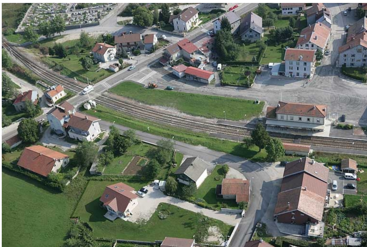
Vue aérienne, depuis l'ouest.
