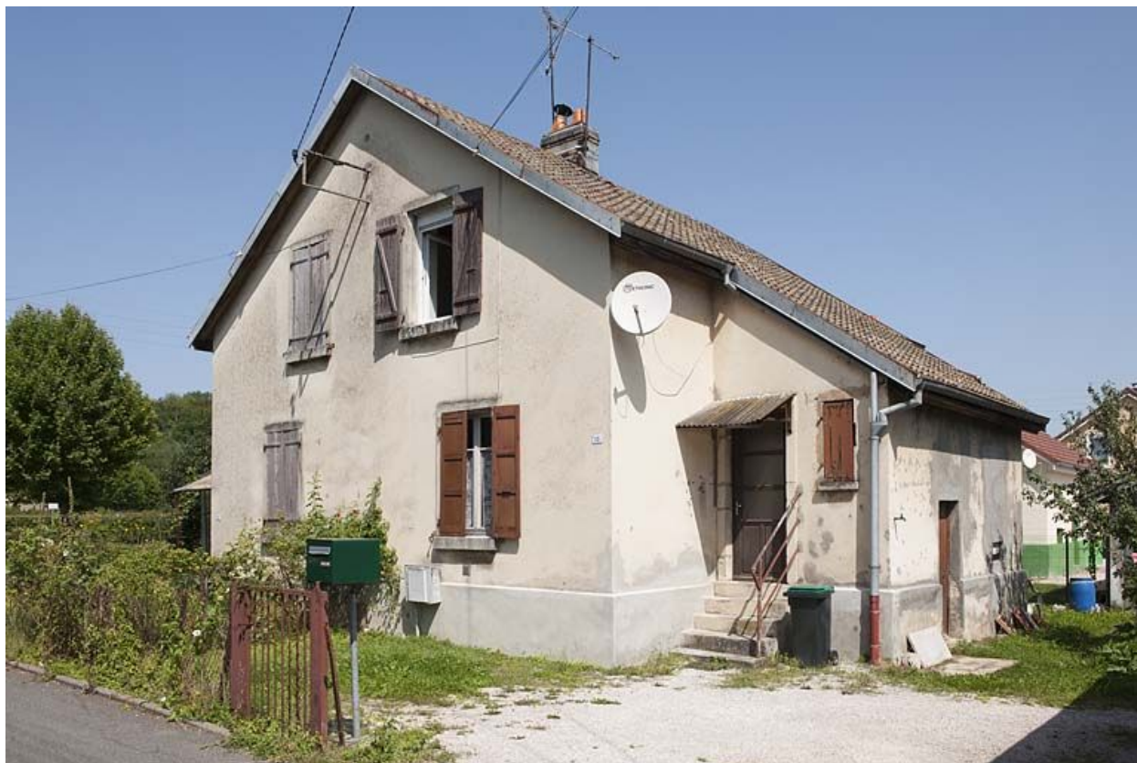
Maison jumelée vue de trois quarts droite.
