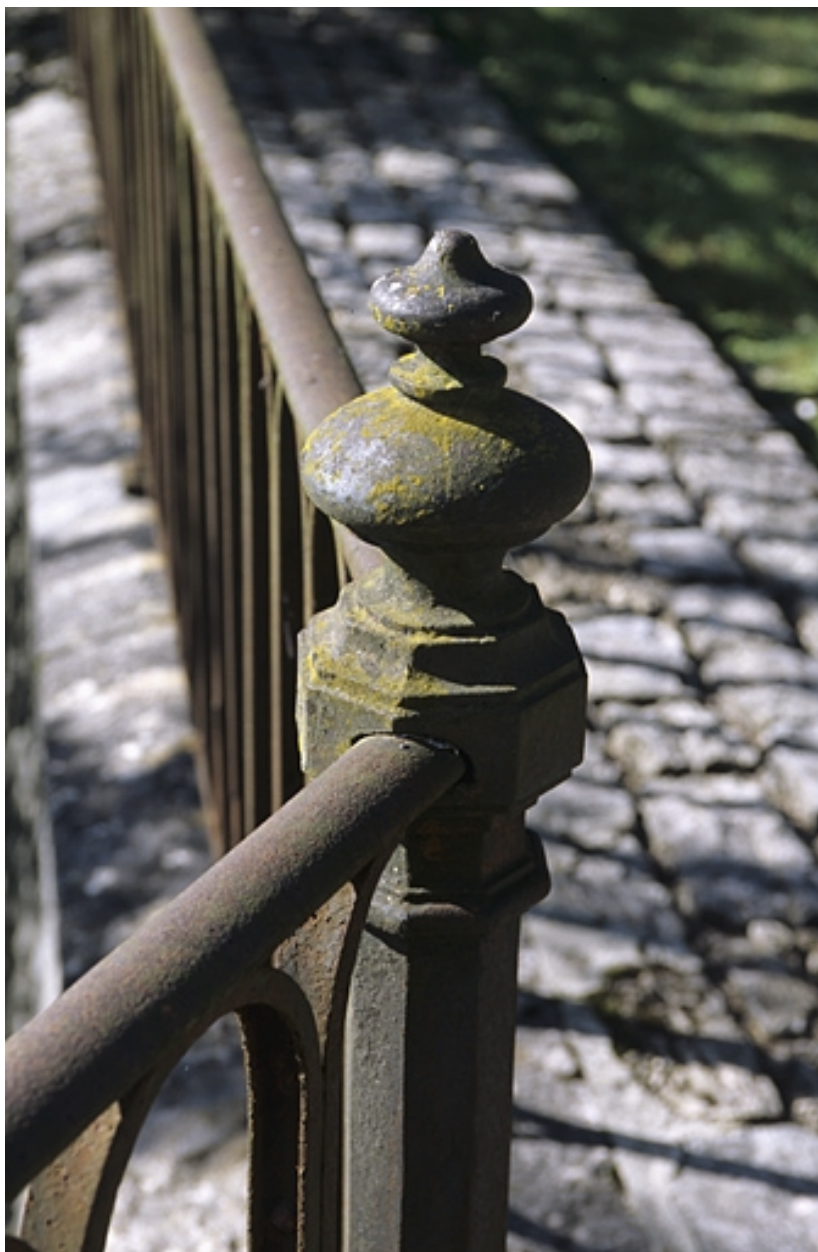
Motif d'amortissement d'un potelet du garde-corps.
